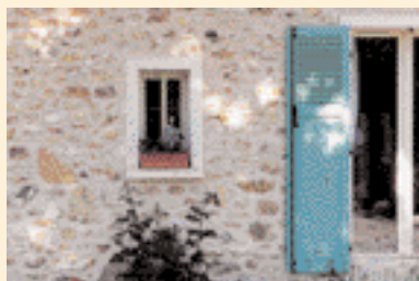
Enduit à pierre vue. ▲
