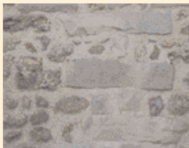
L'enduit affleure entre moellons de meulière et les pierres taillées de grès. ▼
