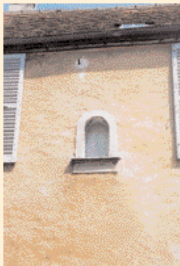
▲ L'enduit couvrant doit être conservé en évitant de mettre à nu la pierre.
