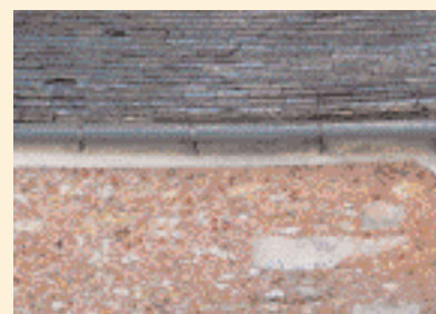
Enduit coloré à la brique pilée. ▼
