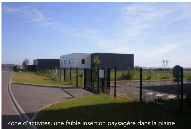
La Gare Méré – Montfort porte d'entrée de la commune et du PNR
